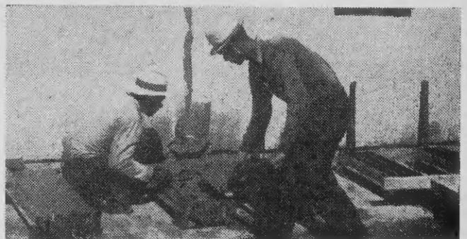
Banda drechi nos ta mira Miguel Brisio i Miguel Wouters trahando trapinan di beton pa tankinan. E sandblasternan cu ta forma parti di e departamento di Beton, ta aprehe banda robéz.
